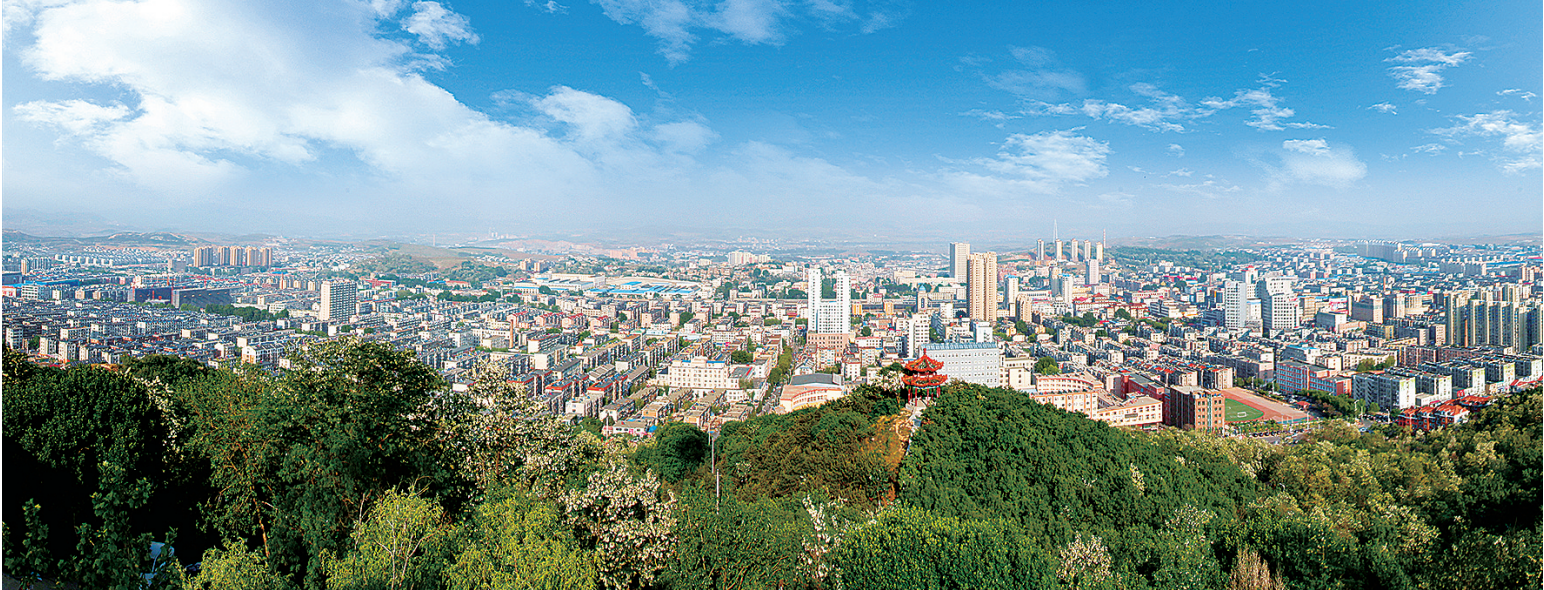
持续深化“瓦长”一体化发展,奋力打造区域协调发展示范样板。图为俯瞰蓝天白云下的瓦房店市区(资料图片)。
