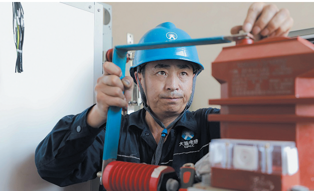
施工人员在狭小空间紧张作业。 郭铸辉 摄(大连电建集团提供)
