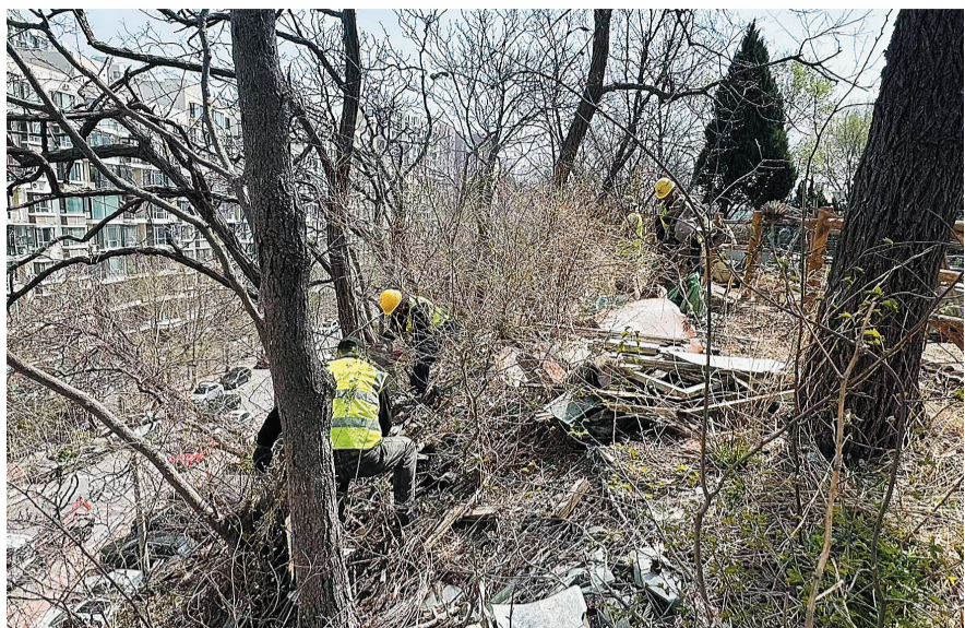
工作人员深入坡体区域，集中清理建筑垃圾、枯枝杂物。 杨薪弘 摄
