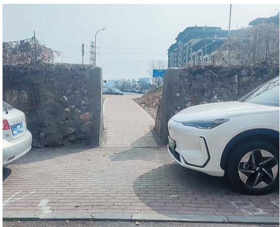
修好的围墙。 丛霄 摄(周东社区提供)
