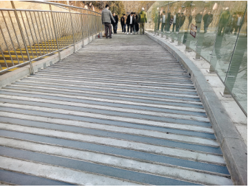
观景地现场防滑设施已铺设完毕。杜迈 摄
